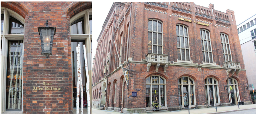
Abb. 43 a und b: Am Gebäude der Patriotischen Gesellschaft Hamburgs erinnert noch ein Schriftzug an den Standort des ehemaligen Rathauses.
