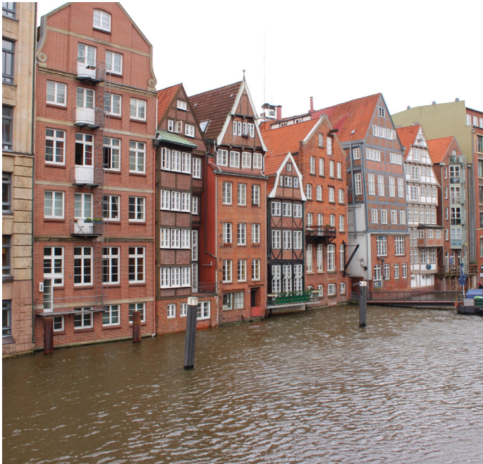
Abb. 5: Rückwärtige Ansicht der Deichstraße vom Nikolaifleet aus.
